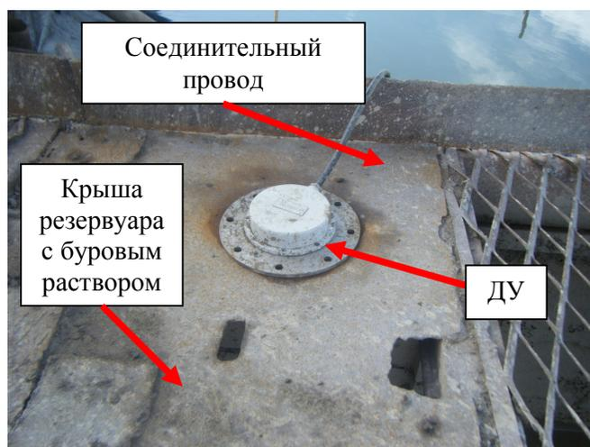
Рис. 17. Монтаж датчику уровня (ДУ) на буровой
