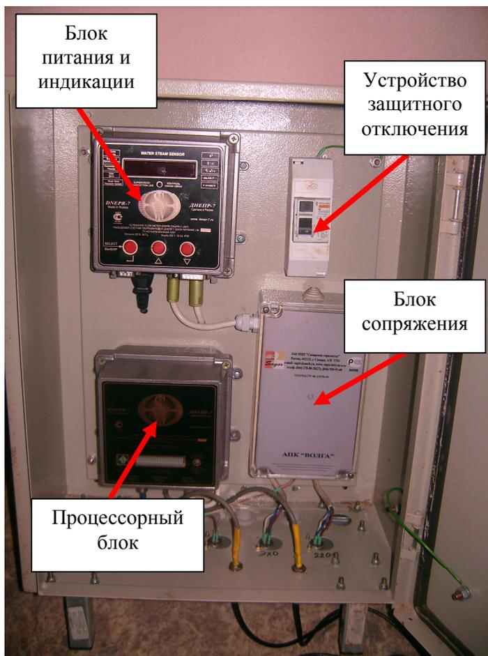
Рис. 18. Внешний вид датчика расхода на входе
