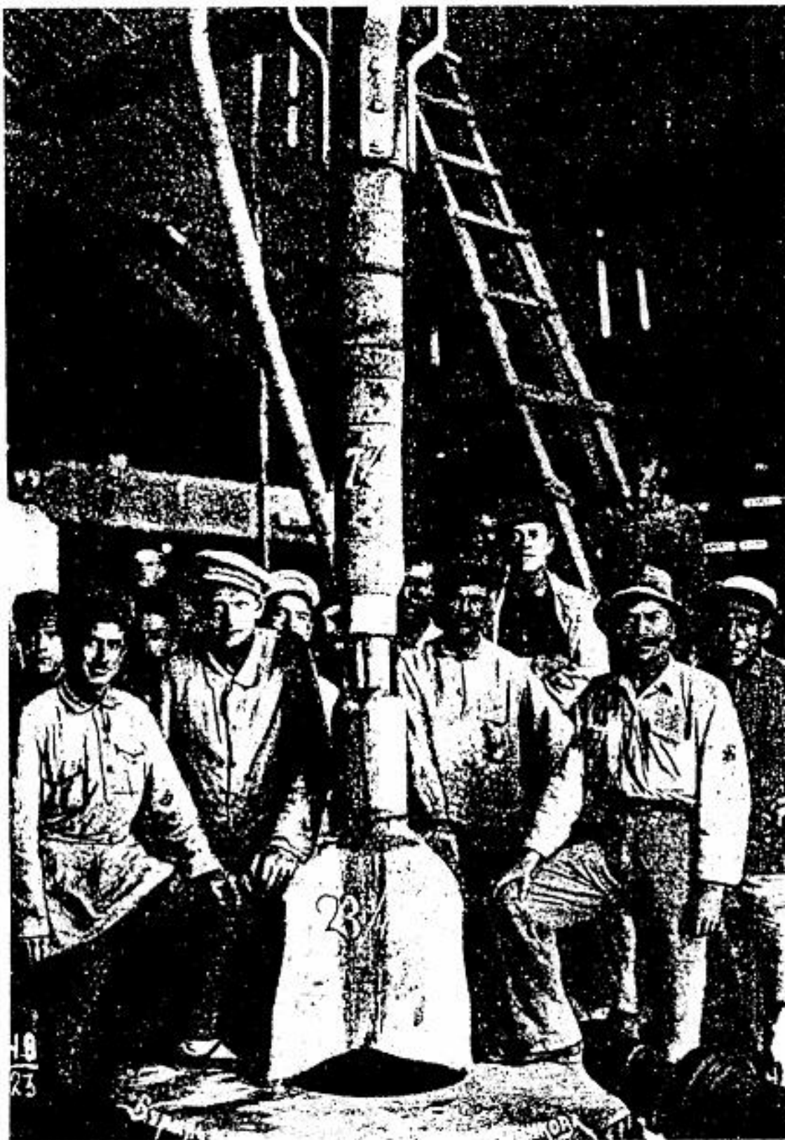
Рисунок 3.10 - Один из рабочих моментов (1925 г.) испытаний турбобура Капелюшникова М.А. с трехлопастным долотом
