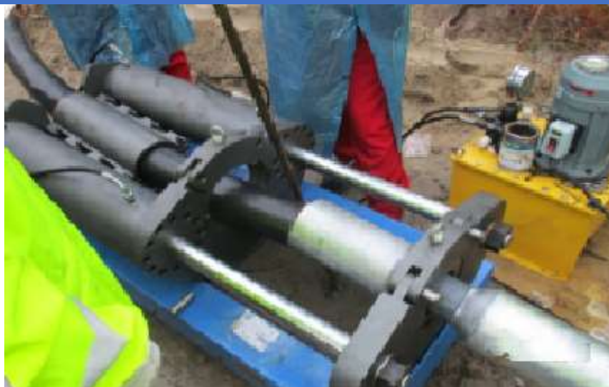
Рис.4. Обжимная муфта для ремонта дефектных мест в полевых условиях
